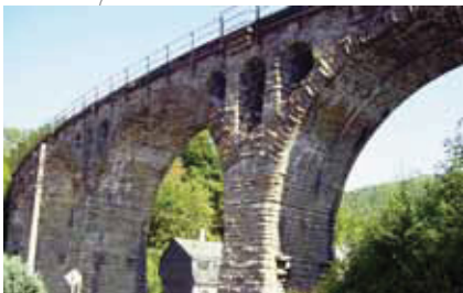
Überspannung des Tales durch Viadukt
