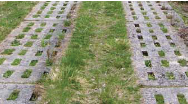
Wabenplatten im Bereich des Kolonnenweges
